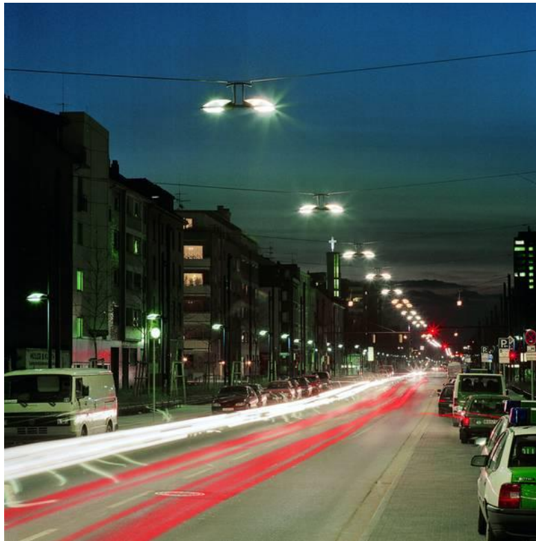
Slika 12. Osni raspored izvora svjetlosti s nosivim žicama poprečno na cestu
