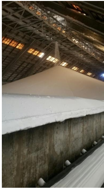
Slika 11: Prikaz skladišta UREA-e
