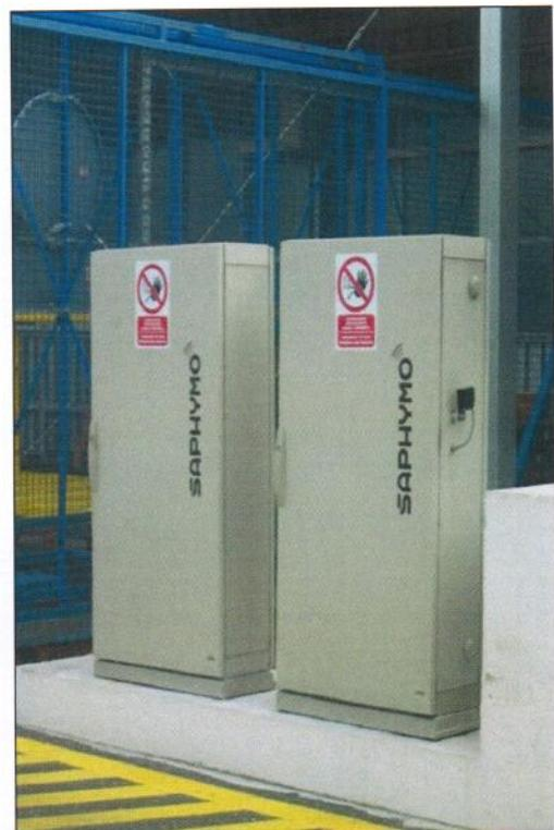
Slika 22. Detektori radioaktivnosti
