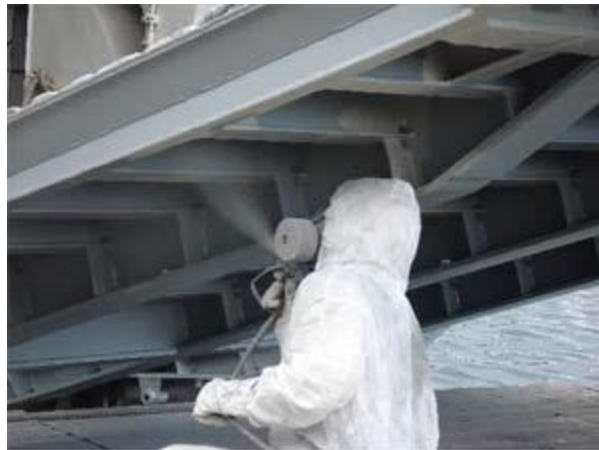
Slika 15. Nanošenje premaza bezračnim prskanjem
