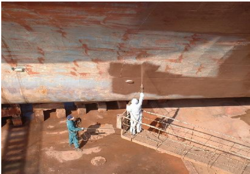
Slika 12. Nanošenje temeljnog premaza
