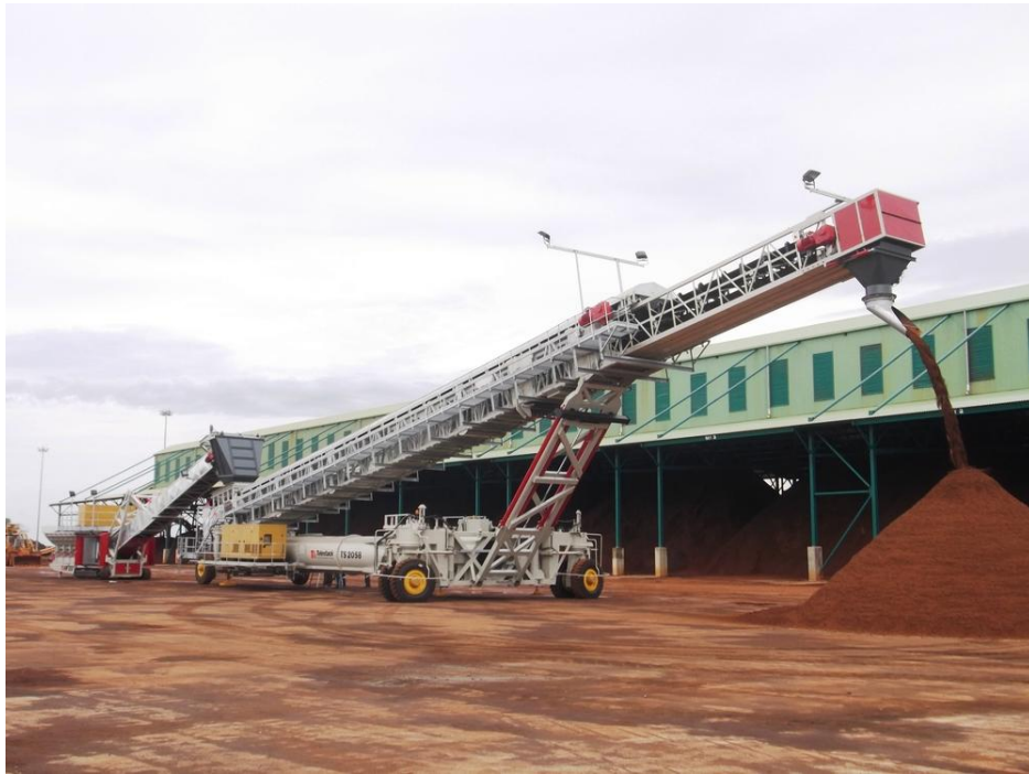
Slika 15. Terminal za rasute terete
