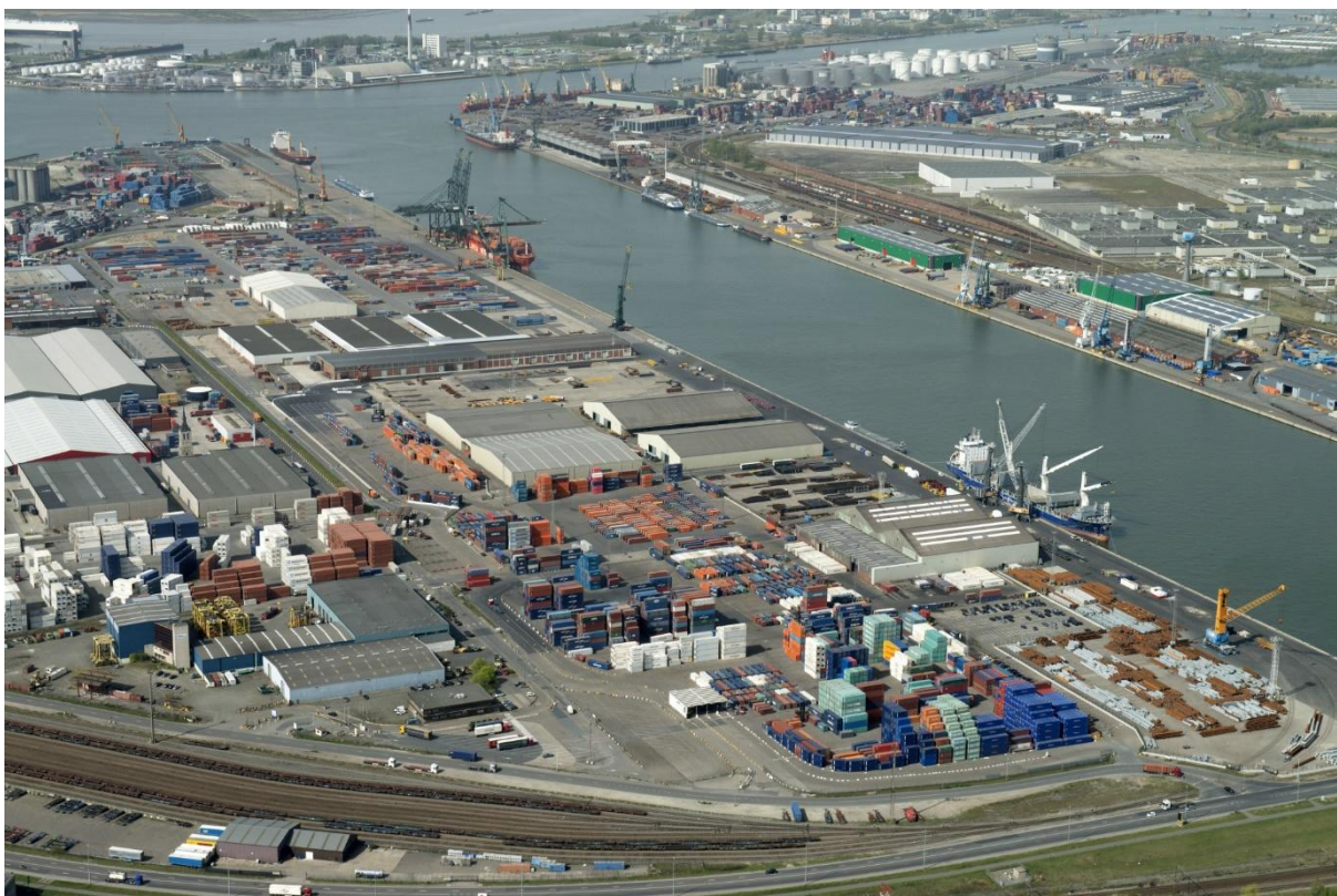
Slika 22 PSA / NHS Churchill Terminal sa skladištima
