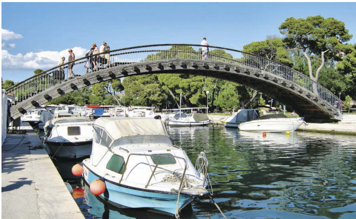
Slika 6. Pješački drveni most preko Foše u Trogiru
