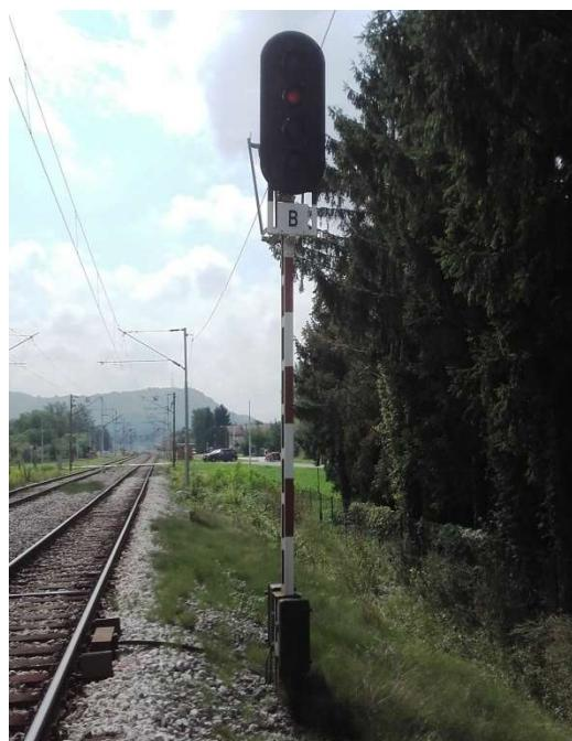
Slika 3. Ulazni signal „B“ u kolodvoru Zaprešić
