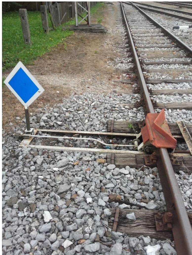
Slika 6. Iskliznica broj 5 u kolodvoru Zaprešić
