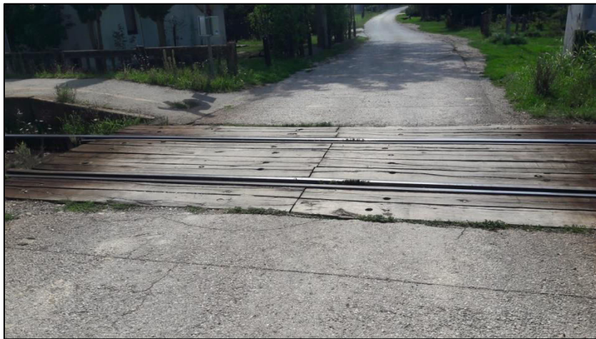
Slika 24. Prikaz podloge na željezničko-cestovnom prijelazu „Širinec“
