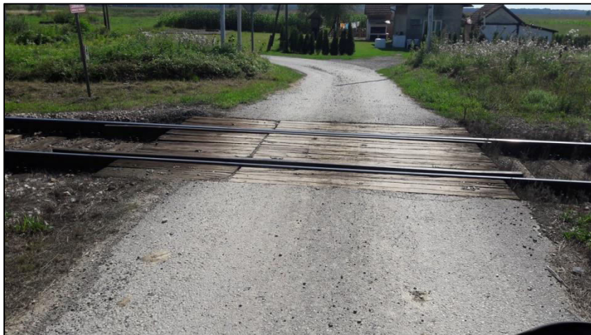
Slika 18. Prikaz stanja pragova na željezničko-cestovnom prijelazu „Deanovec 1“
