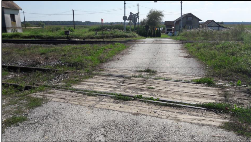
Slika 17. Prikaz stanja pragova na željezničko-cestovnom prijelazu „Deanovec 1“
