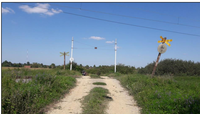
Slika 20. Željezničko cestovni prijelaz „Deanovec“ iz smjera juga
