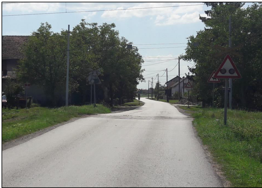
Slika 5. Željezničko-cestovni prijelaz osiguran sa svjetlosno-zvučnom signalizacijom i "Andrijinim križem", Okešinac
