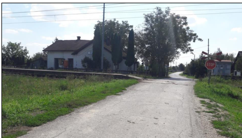
Slika 22. Željezničko-cestovni prijelaz „Širinec“ iz smjera sjevera
