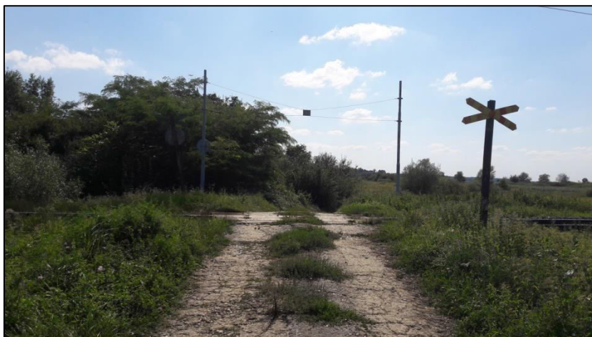
Slika 19. Željezničko-cestovni prijelaz „Deanovec“ iz smjera sjevera
