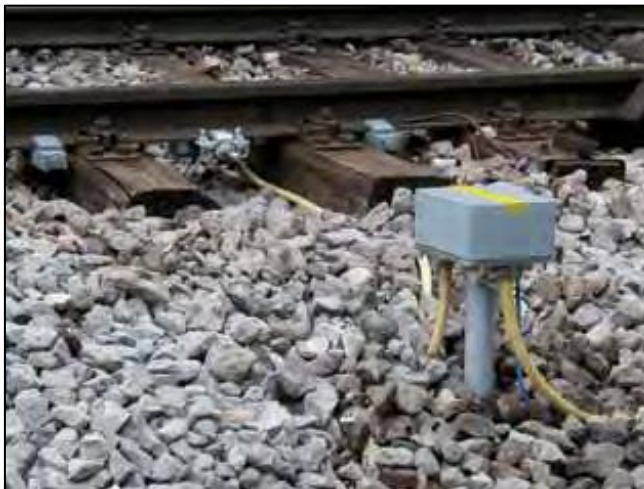
Slika 13: Prikaz kućišta vanjske elektronike (VUR)
