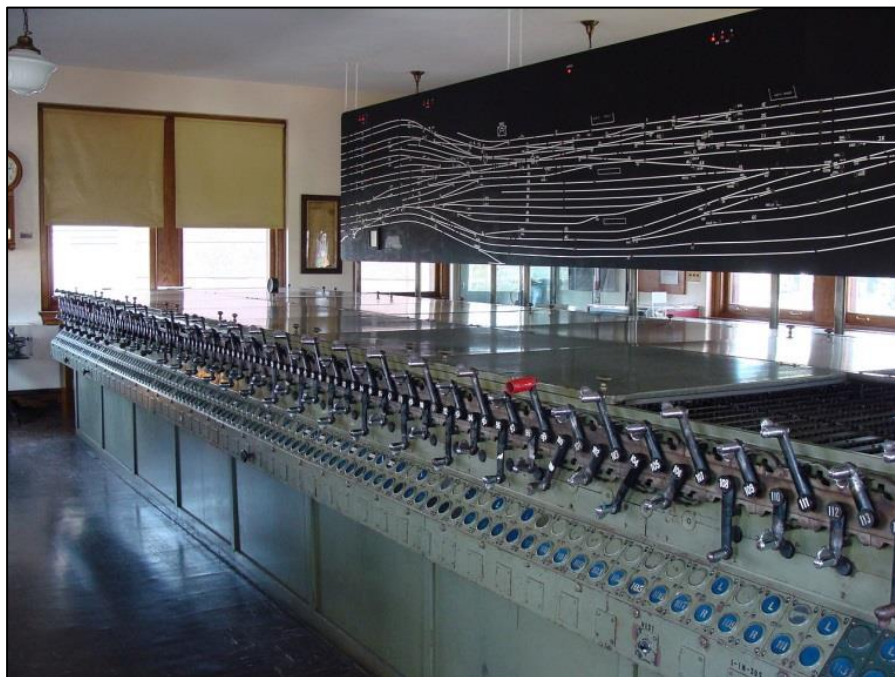
Slika 1: Izgled starijeg tipa kolodvorskog (staničnog) uređaja (1950. godina)
