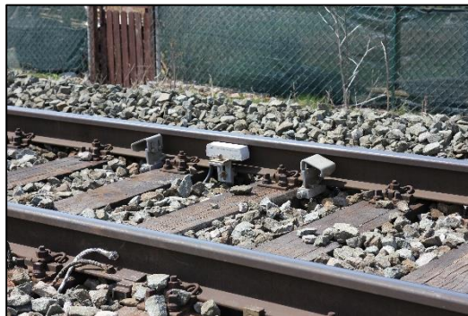
Slika 15: Prikaz senzora ZK24-2
