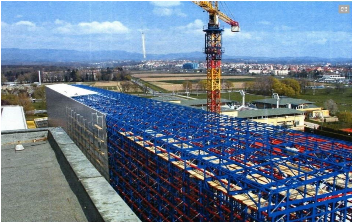
Slika 25.: Izgradnja Kraš visokoregalnog skladišta Izvor: [12]
