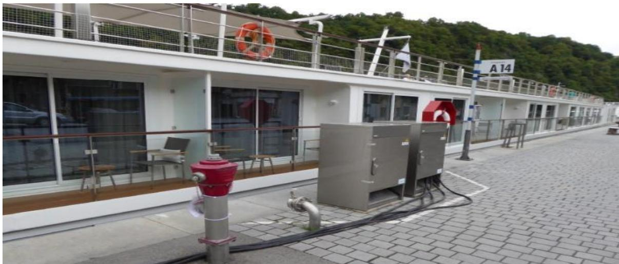
**Slika 20.** Prikaz pristana u luci Passau te priključaka za električnu energiju, vodu i odvod
