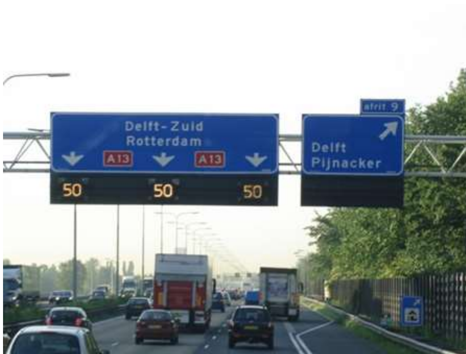
Slika 16 – Primjer promjenjivih prometnih znakova na Nizozemskim cestama, Izvor [18]
