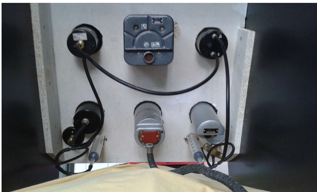
Slika 28. Instalacija pitot-statičkog sustava
