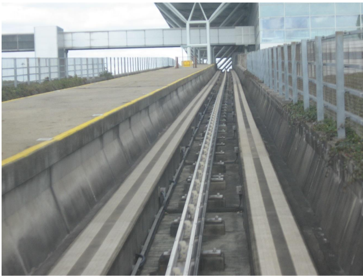
Slika 6. Prikaz gornjeg ustroja pruge s trećom tračnicom u sredini
