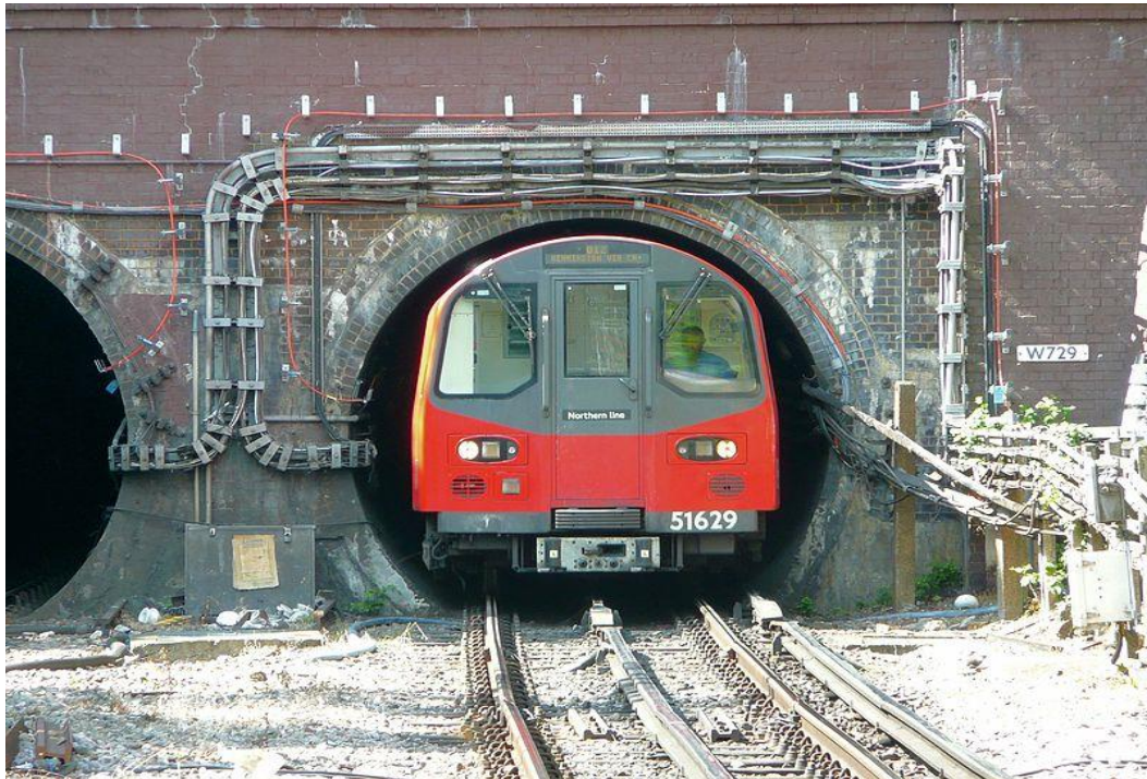
Slika 1. Karakterističan oblik tunela - The Tube
