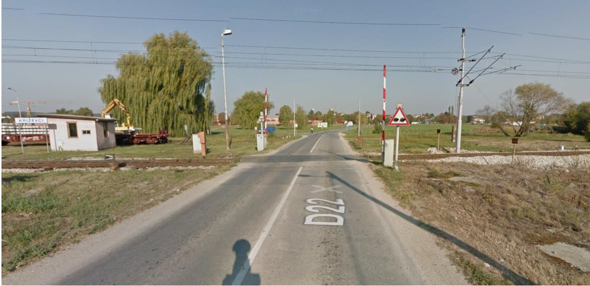
Slika 19. Pružni prijelaz na državnoj cesti D22 u smjeru Križevaca
