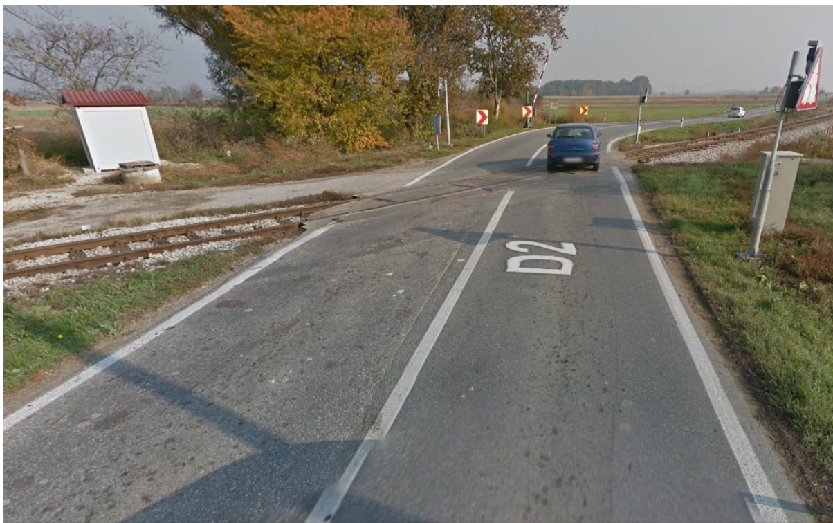
Slika 20. Pružni prijelaz na državnoj cesti D2 između Virja i Đurđevca
