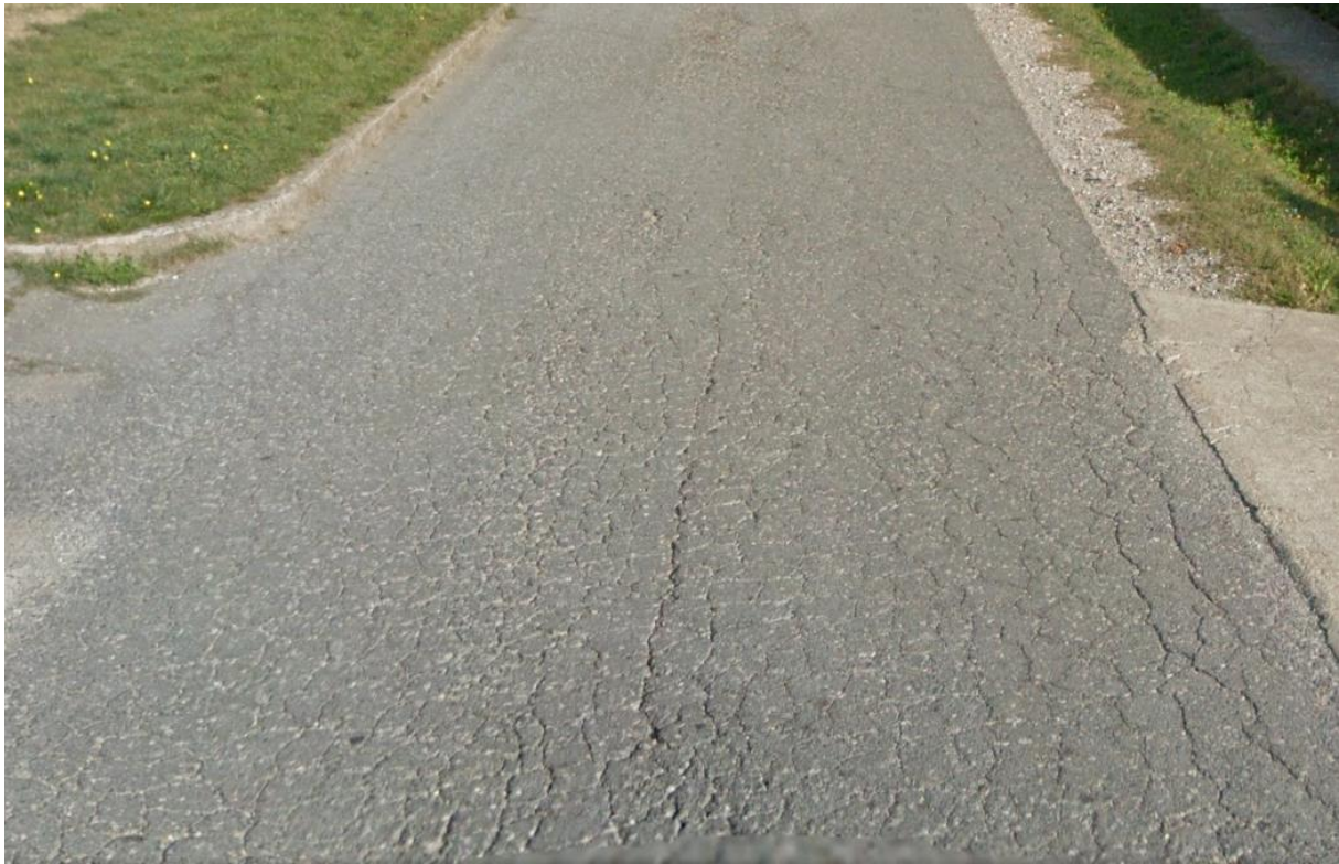
Slika 12. Dio kolnika na lokalnoj cesti LC 26138
