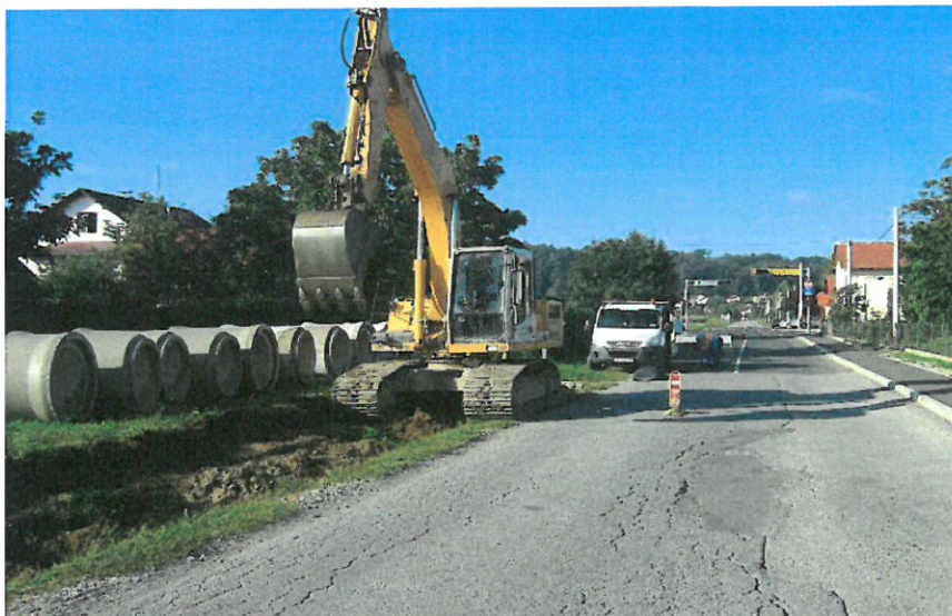
Slika 6. Prikaz postojećeg stanja kolnika županijske ceste 2029
