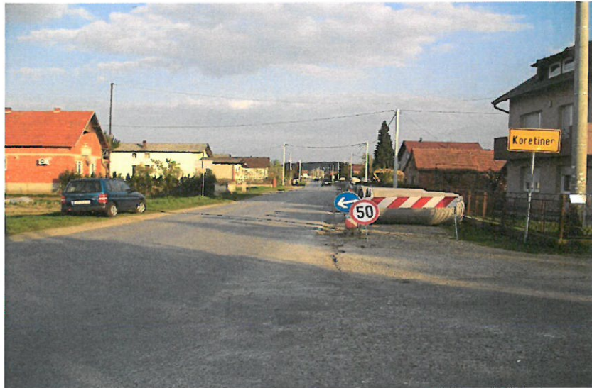
Slika 5. Radovi na županijskoj cesti 2029 u mjestu Koretinec
