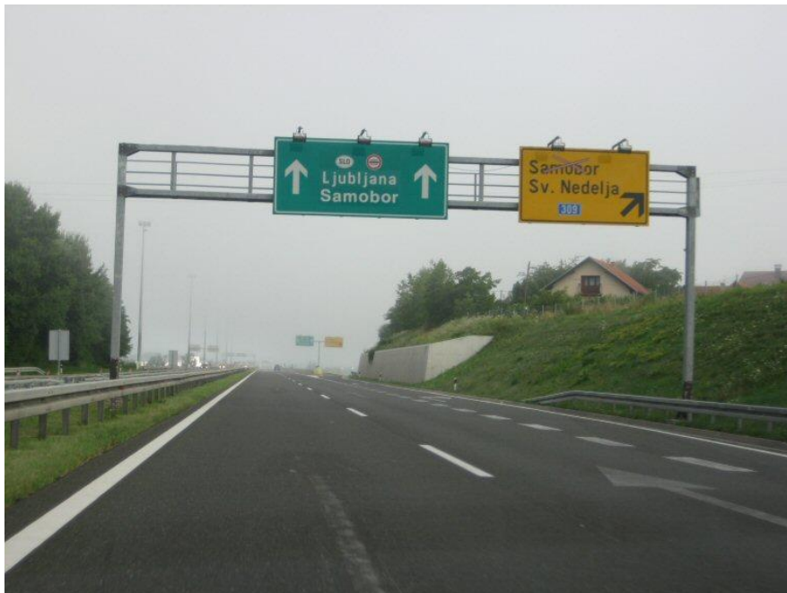
Slika 1. Dionica autoceste A3 (izlaz Samobor)
