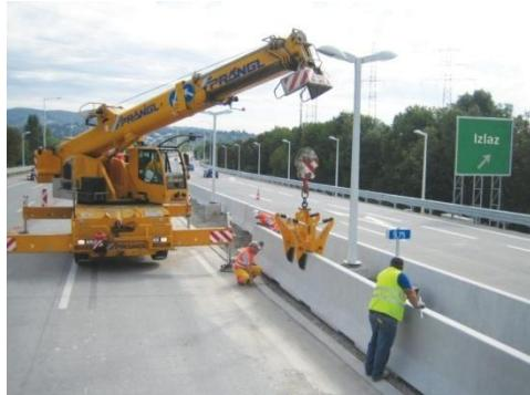
**Slika 7. Postavljanje betonske zaštitne ograde tipa *New Jersey* u razdjelnom pojasu**
