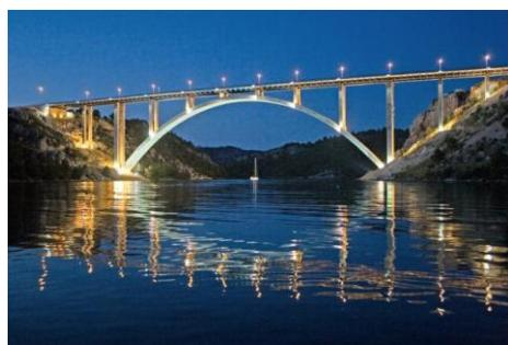
**Slika 4. Most Krka (primjer lučnog armiranobetonskog mosta)**
