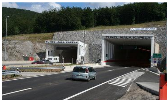
Slika 3. Tunel Mala Kapela
