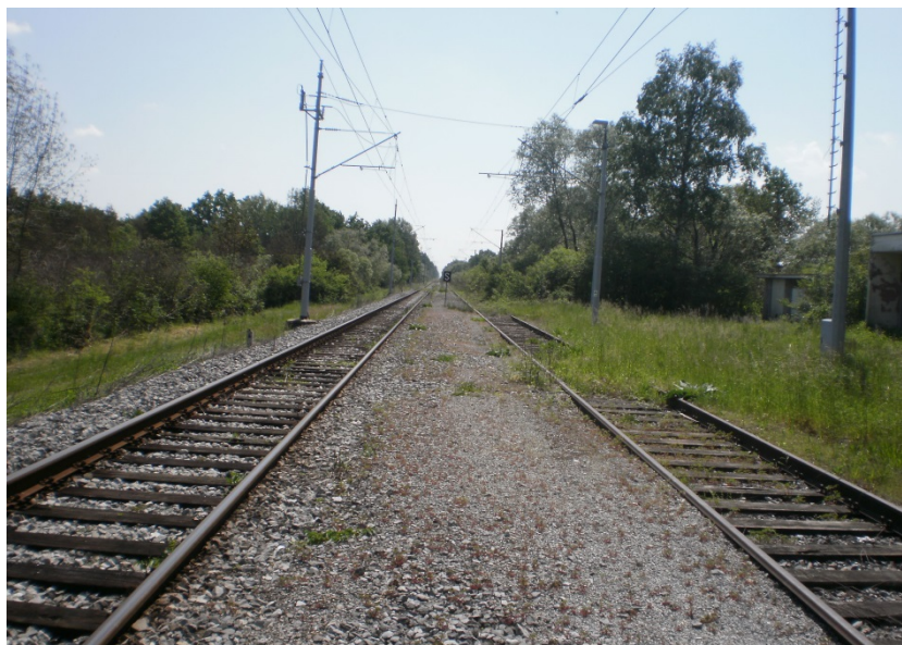
Slika 23: Današnji izgled kolosijeka u nezaposjednutom kolodvoru Staza
