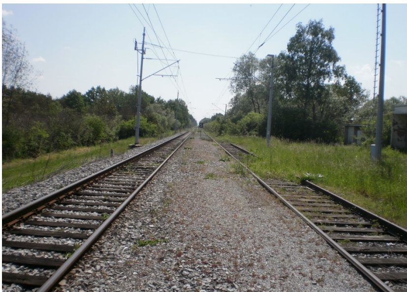
Slika 23: Današnji izgled kolosijeka u nezaposjednutom kolodvoru Staza
