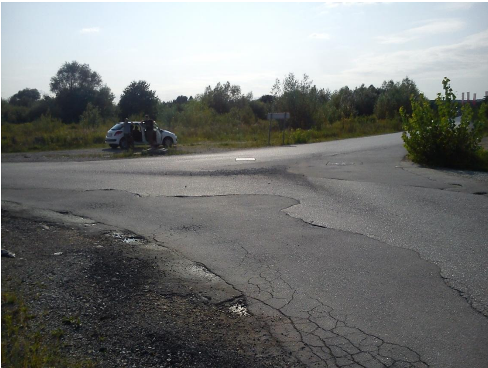
Slika 7. Pogled na raskrižje iz smjera zapada
