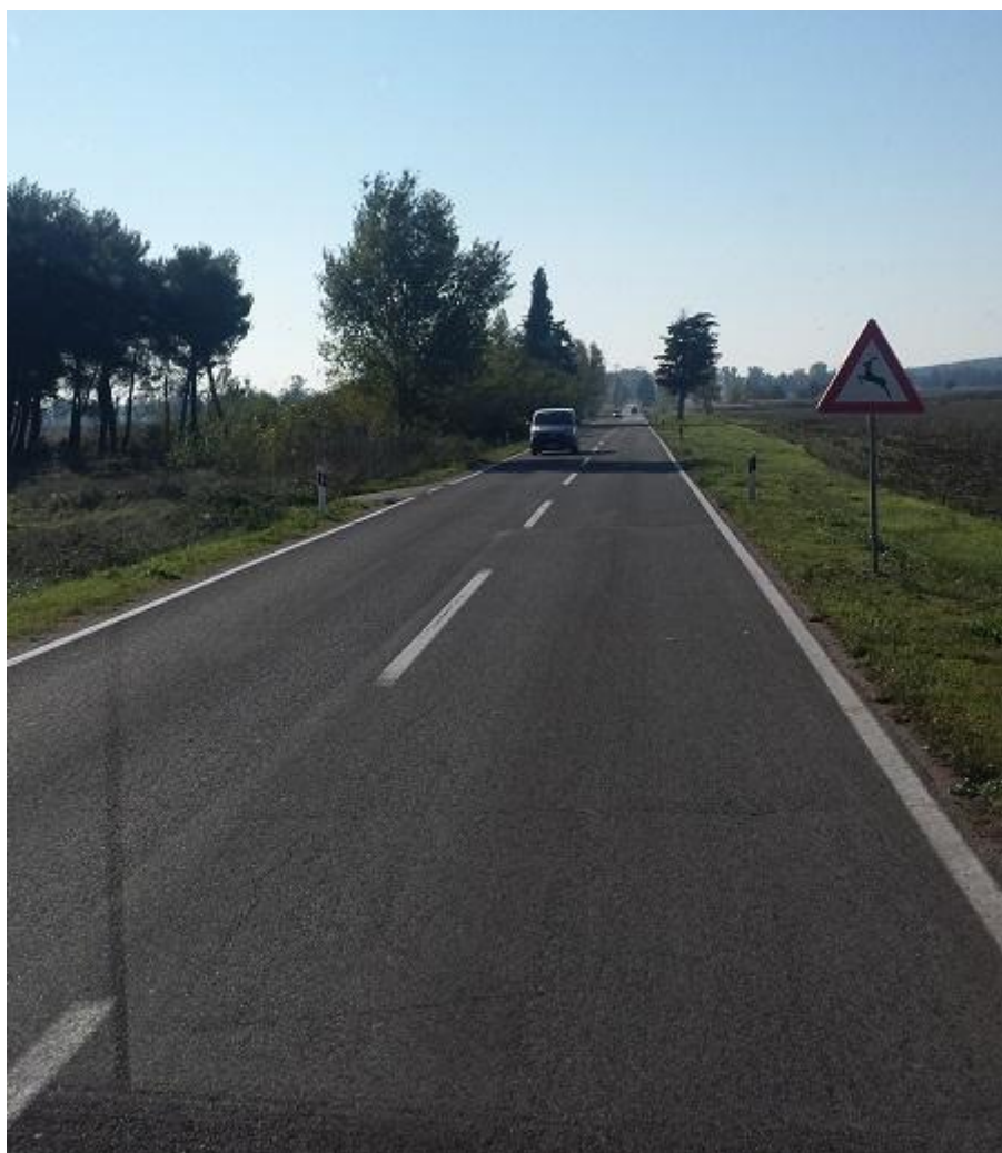
Slika 5.6. Prikaz prometnih trakova, rubnih trakova i bankine
