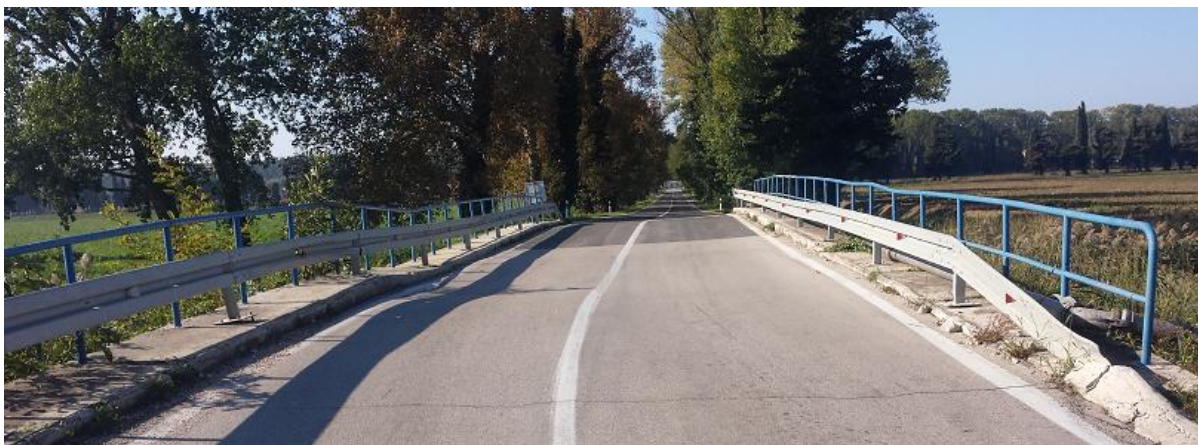
Slika 5.9. Prikaz zadiranja raslinja u slobodni profil
