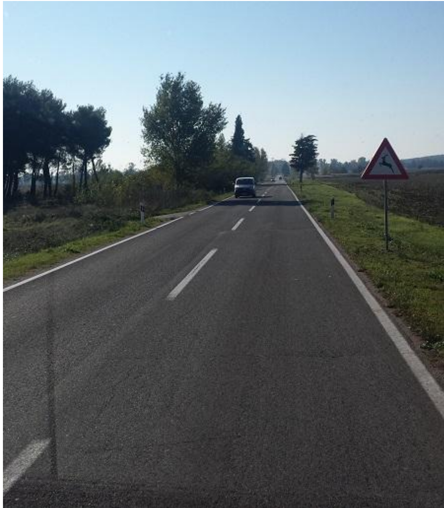
Slika 5.6. Prikaz prometnih trakova, rubnih trakova i bankine
