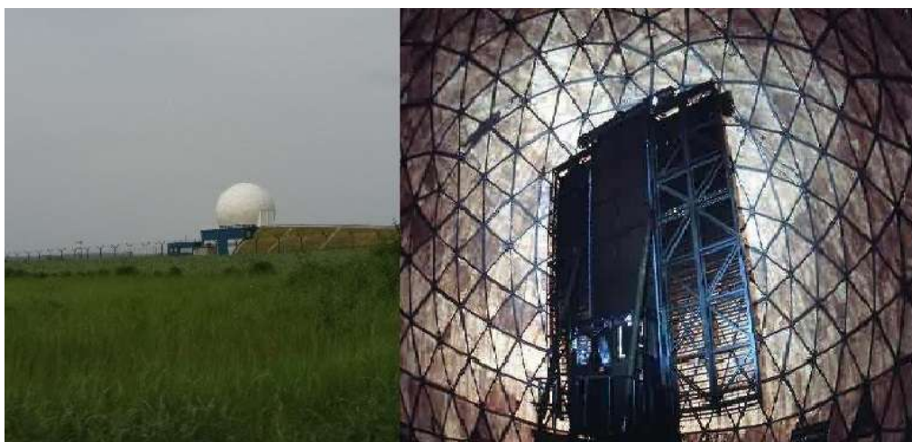
Slika 29. Vanjski izgled radara AN/FPS 117 te pogled na radar iz unutrašnjosti radarske kupole [14]
