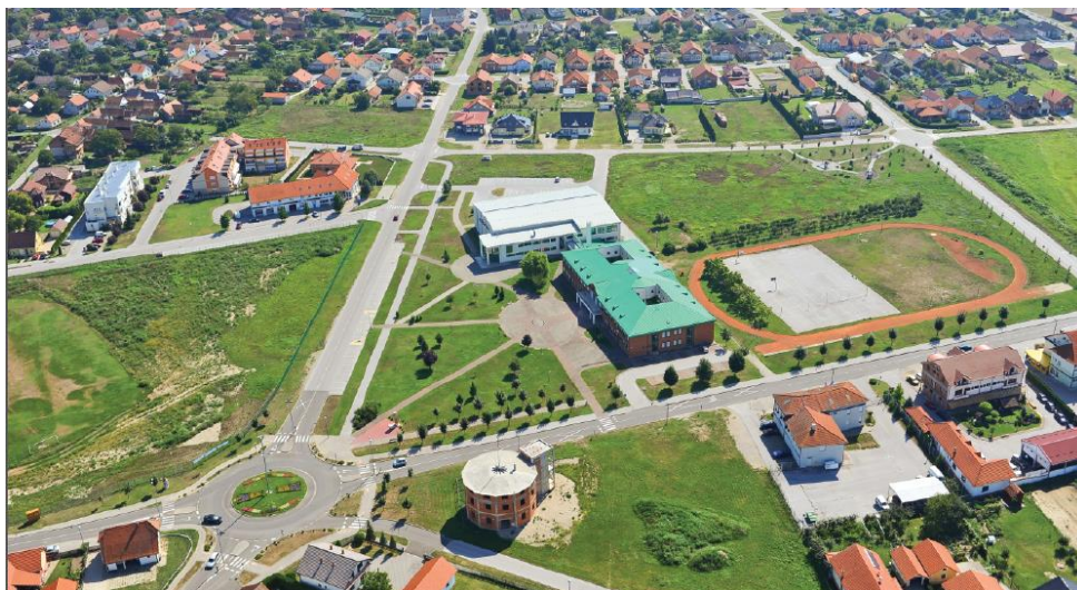
Slika 12. Pogled na prometnice u novim ulicama južnog dijela Preloga
