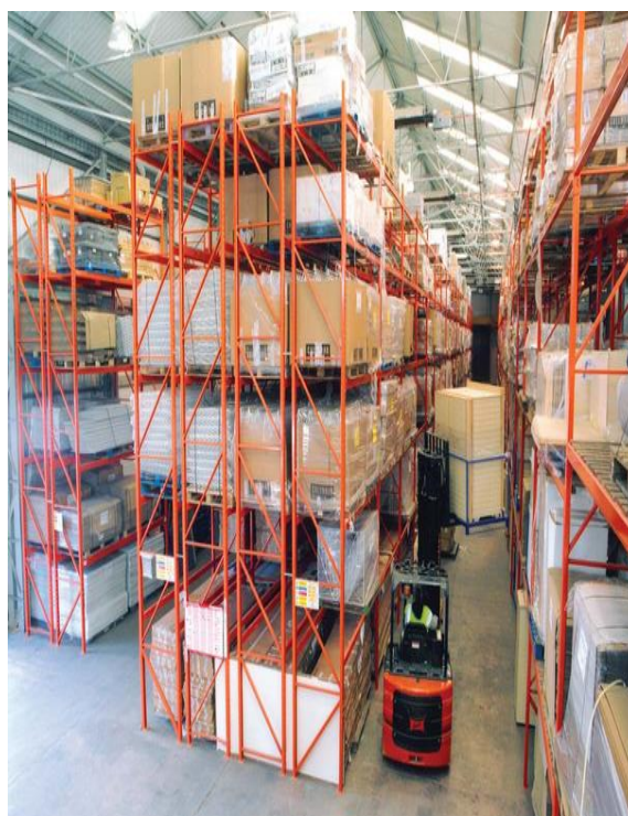
Slika 8. Regal za palete, dvostruke dubine Izvor: https://www.linkedin.com/pulse/20141020071846-101754179-common-warehouse-problems-and-solutions , srpanj 2015.
