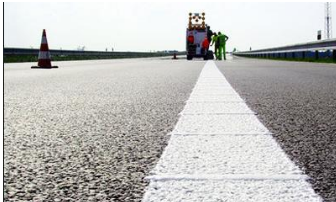
Slika 14. Oznake na kolniku od hladne plastike
