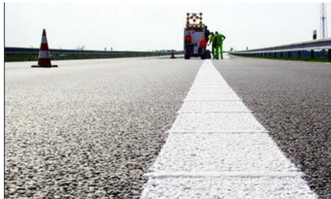
Slika 14. Oznake na kolniku od hladne plastike
