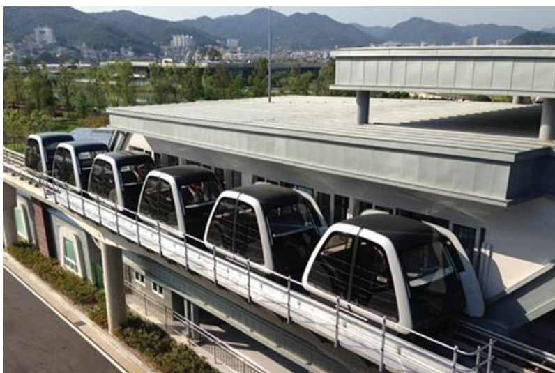
Slika 6. Vozila PRT sustava čekaju na iskrcaj i ukrcaj putnika
