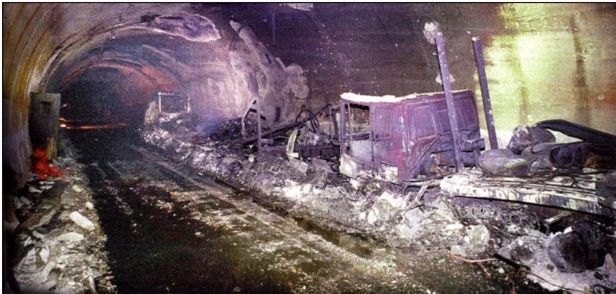
Slika 24. Posljedice požara u tunelu Mont Blanc (1999.), izvor [24]
