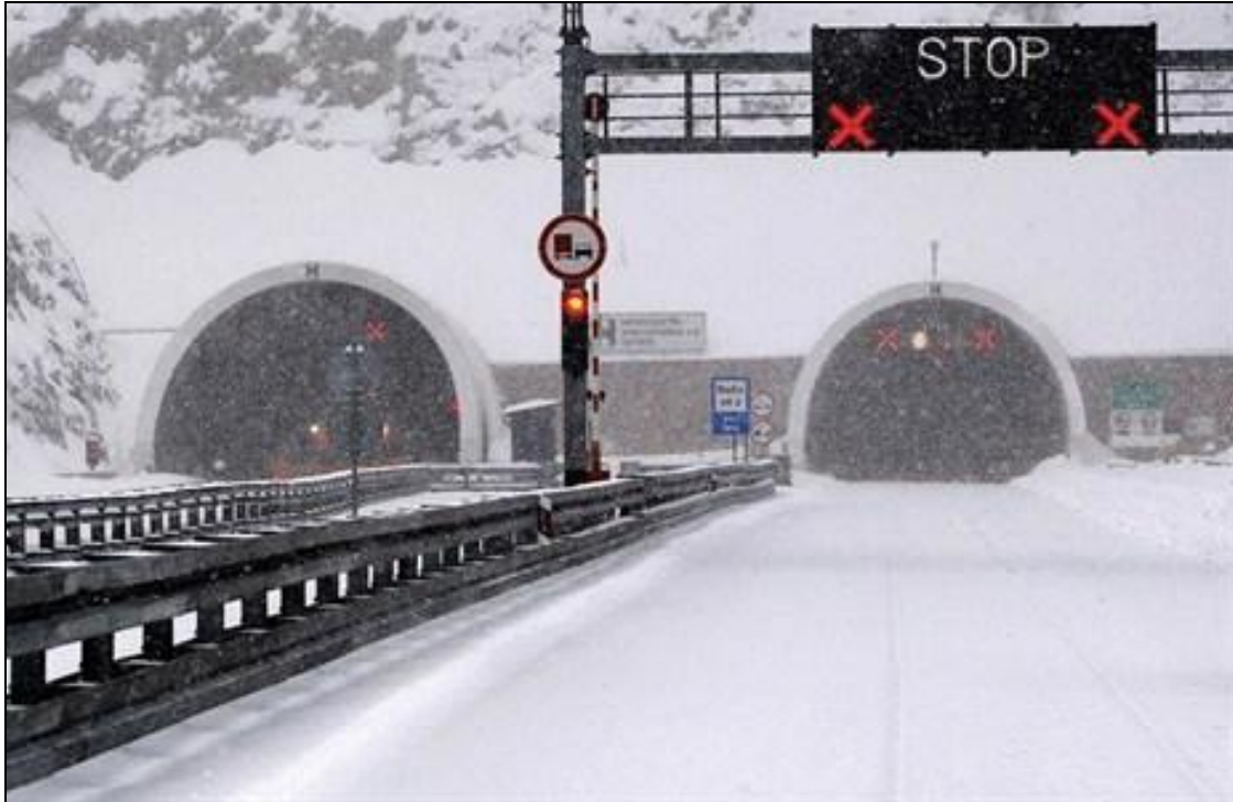
Slika 40. Zatvaranje tunela aktivacijom tunelske opreme, izvor [13]
