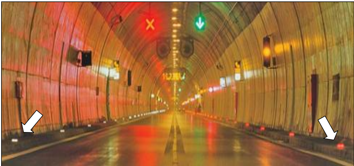
Slika 14. Smjerokazne oznake (markeri – K02) u tunelu, izvor [14]
