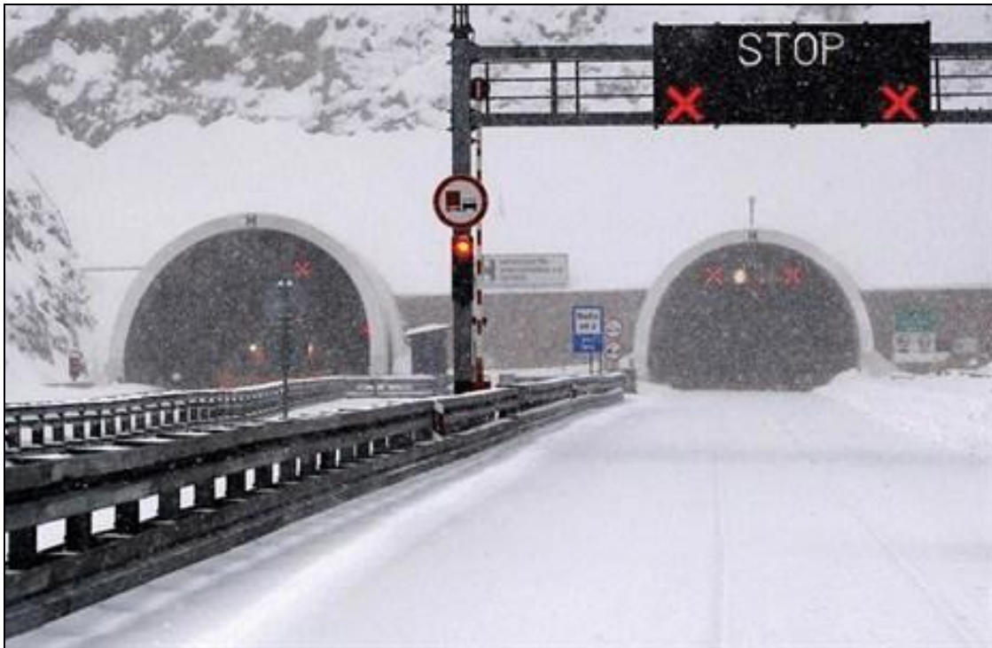
Slika 40. Zatvaranje tunela aktivacijom tunelske opreme, izvor [13]
