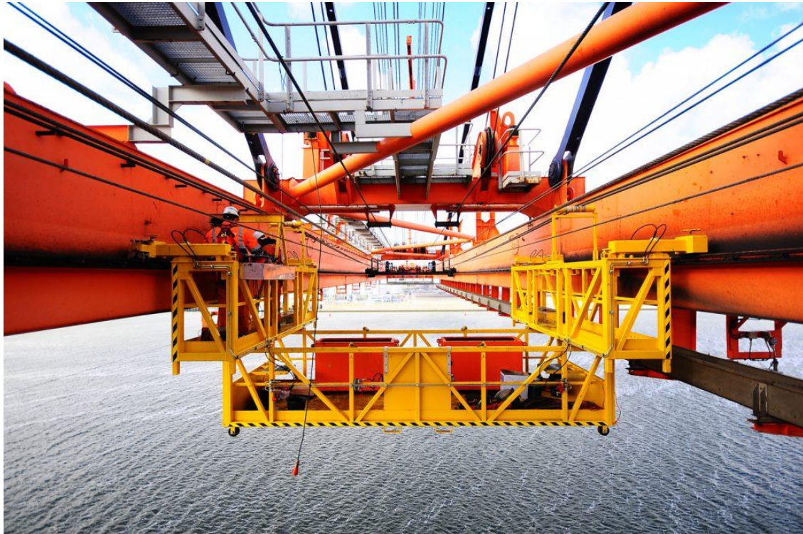
Slika 13. Platforma za obavljanje provjera i popravaka na kontejnerskoj dizalici Izvor: [25]
