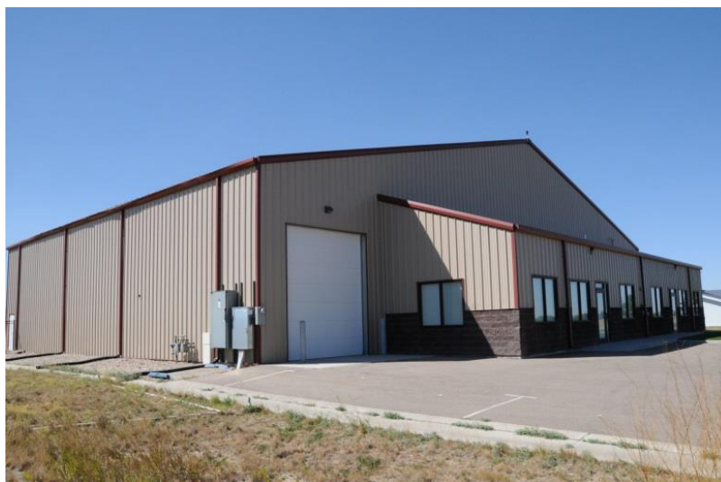
Slika 7. Prizemno (hangarsko) skladište
