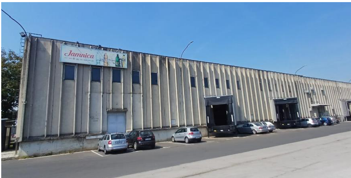
Slika 2. Prizemno skladište od armiranog betona
