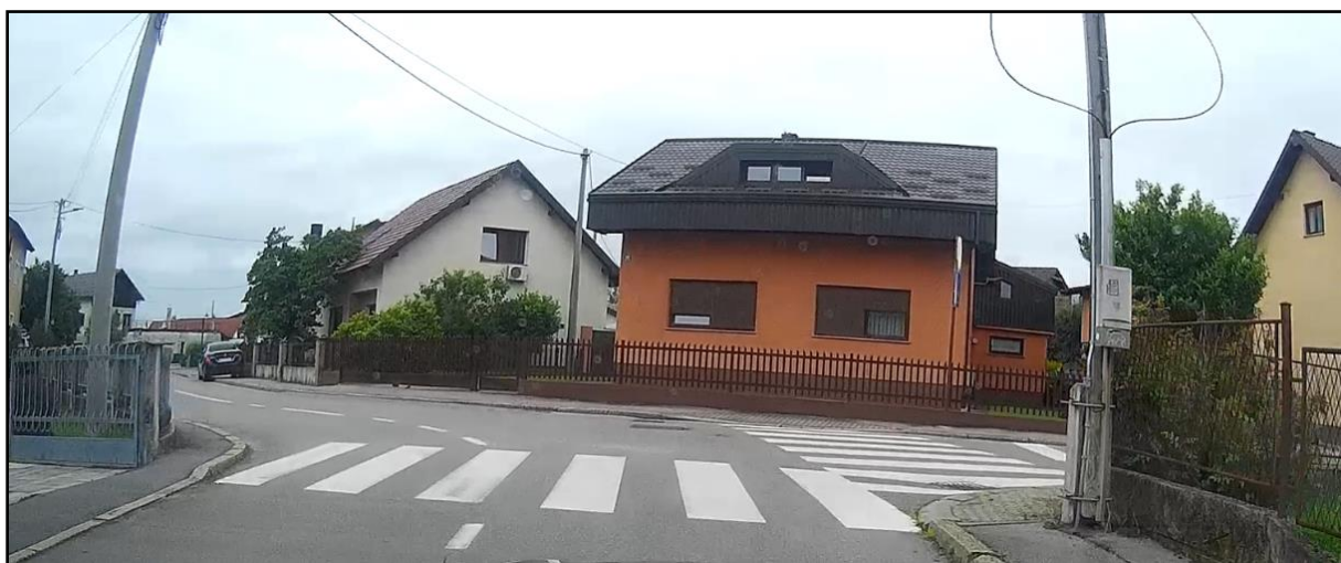
Slika 8. Pješački prijelaz nekvalitetno označen prometnom signalizacijom Izvor: autor
