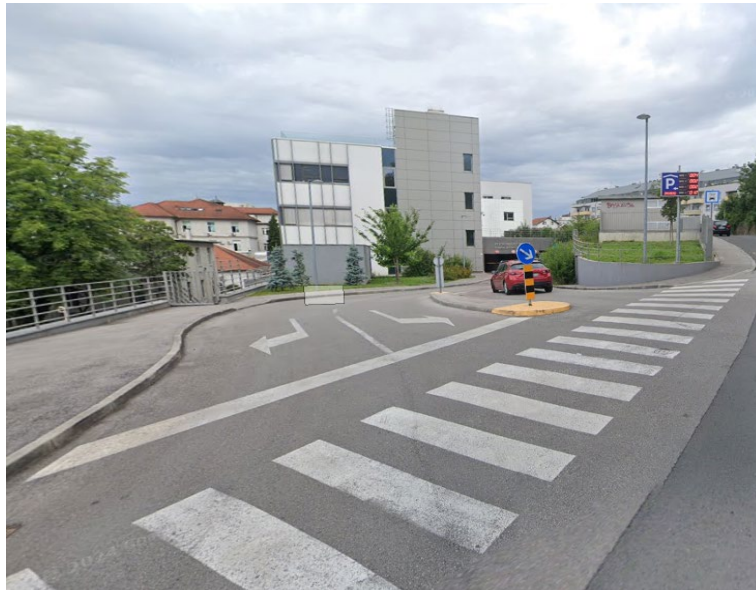
Slika 31. Ulaz u podzemnu garažu "Sveti Duh"
