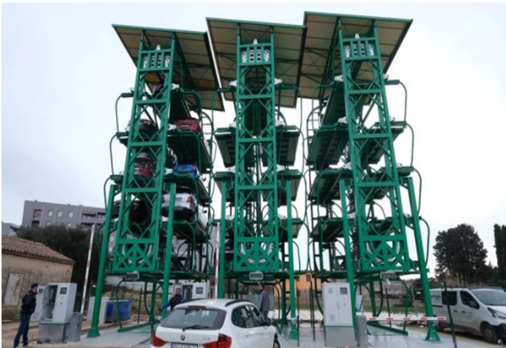
Slika 8. Primjer rotacijske garaže u Puli
