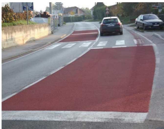
Slika 3. Prikaz implementirane specijalizirane protuklizne Tyregrip podloge u području pješačkog prijelaza u Pavlovcu Zabočkom
