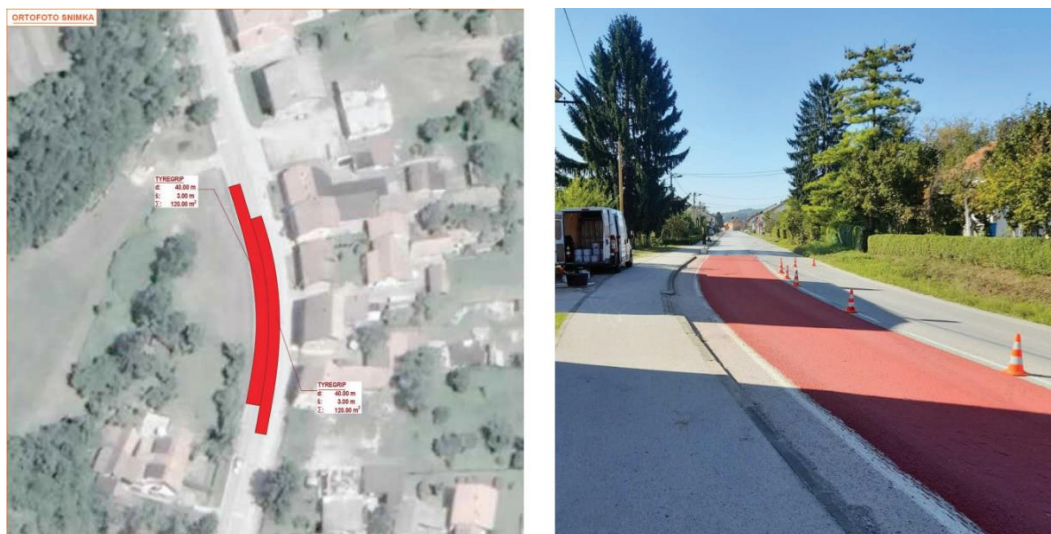
Slika 2. Ortofoto snimka i stvarni prikaz implementirane specijalizirane protuklizne Tyregrip podloge u području horizontalnog zavoja u Ulici Mostanje u Karlovcu
