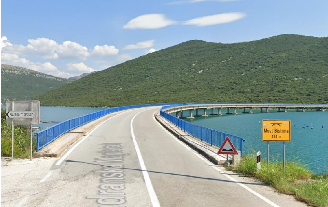
Slika 23. Neadekvatno zaštićen nogostup za kretanje pješaka– Primjer 1 Izvor:[23]
