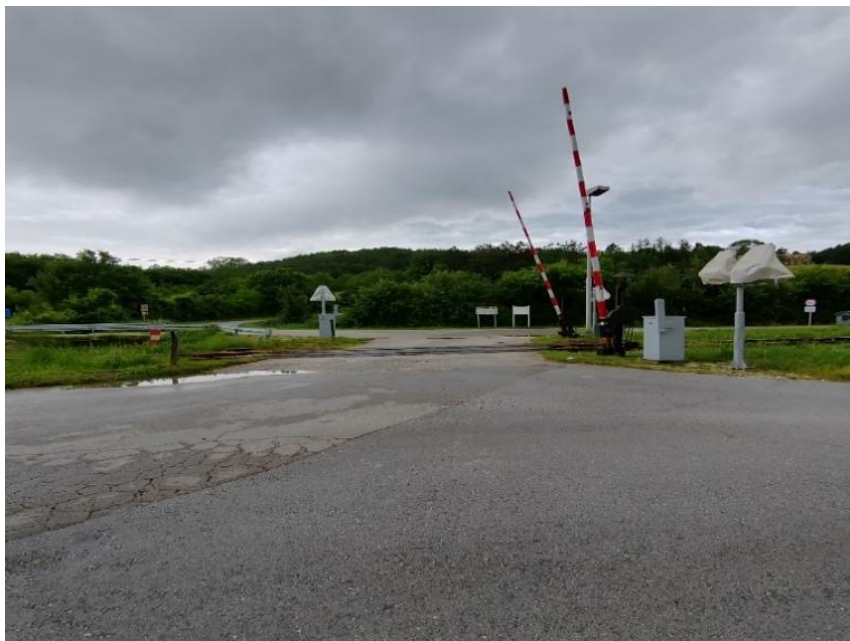
Slika 21. Željezničko-cestovni prijelaz Borut 1 iz smjera juga
