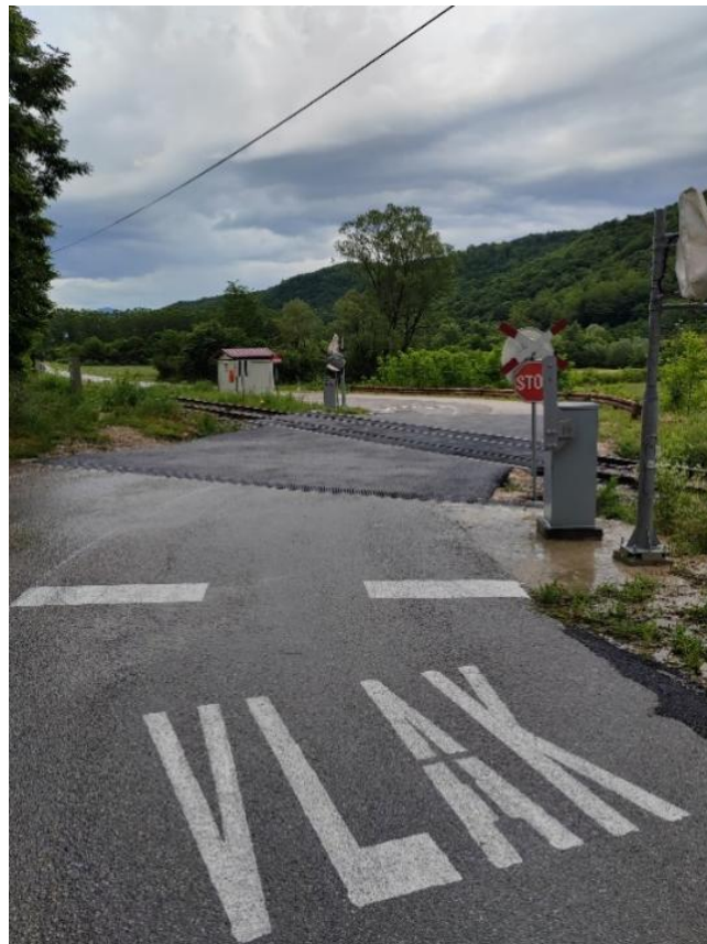
Slika 28. Željezničko-cestovni prijelaz Lovrečići iz smjera sjevera
