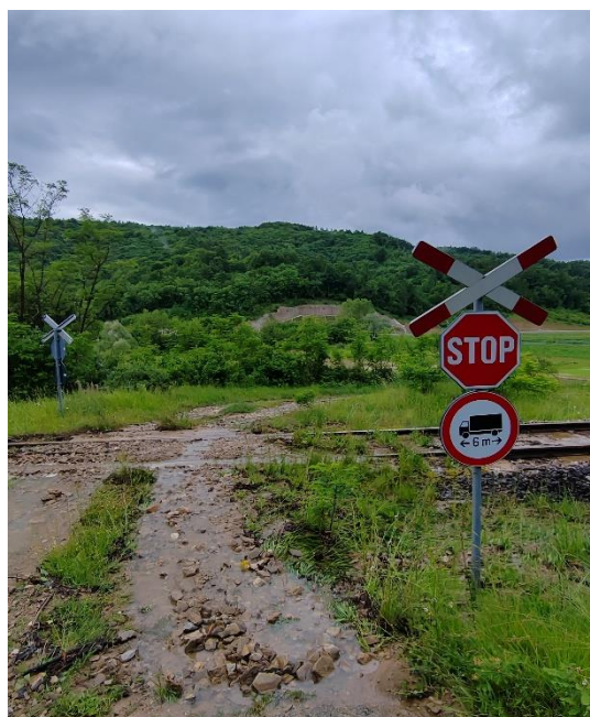
Slika 38. Željezničko-cestovni prijelaz Blagonići 2
