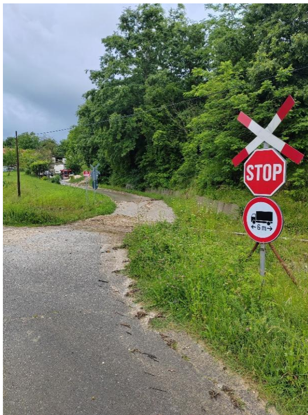
Slika 25. Željezničko-cestovni prijelaz Blagonići iz smjera juga
