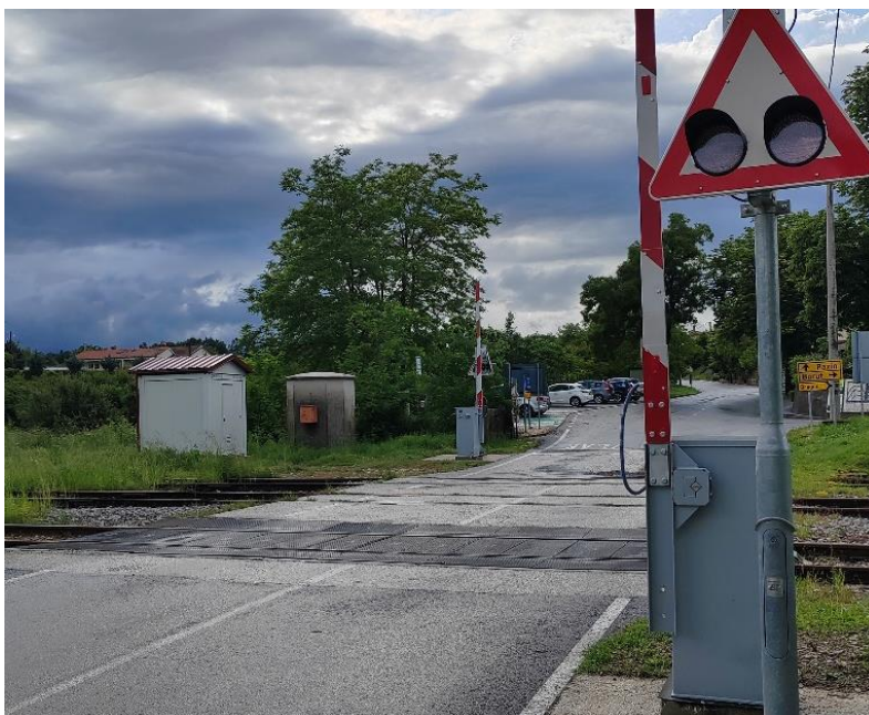
Slika 32. Podloga tvrtke "STRAIL" i SZ uređaje tvrtke "Elektrokem"
