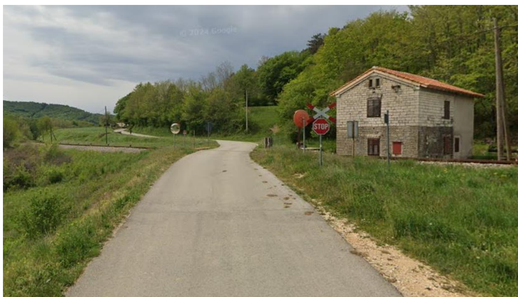
Slika 20. Željezničko-cestovni prijelaz Borut 2 iz smjera juga
