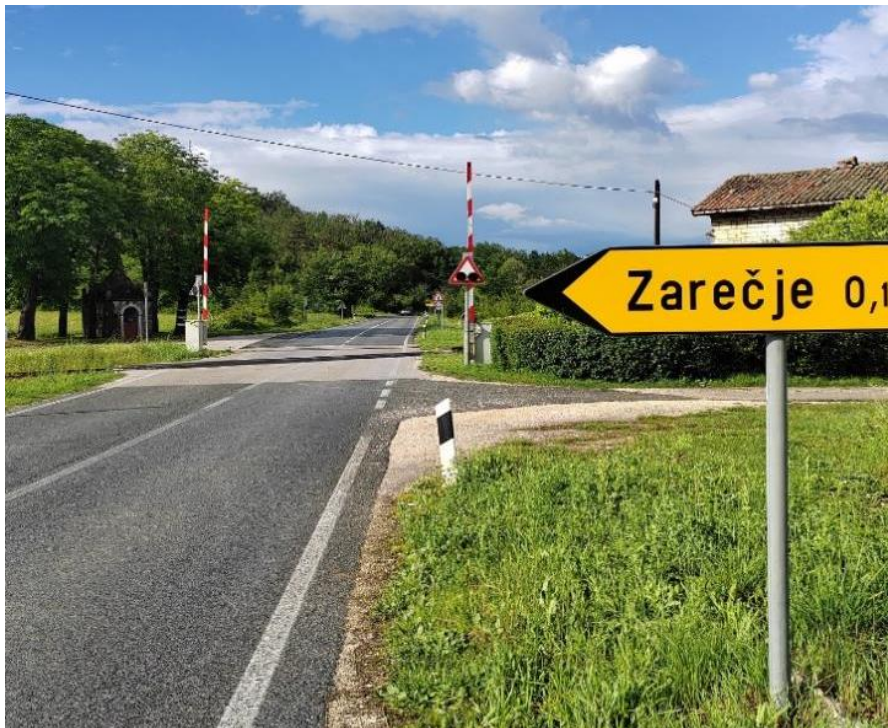
Slika 35. Željezničko-cestovni prijelaz Zarečje iz smjera juga
