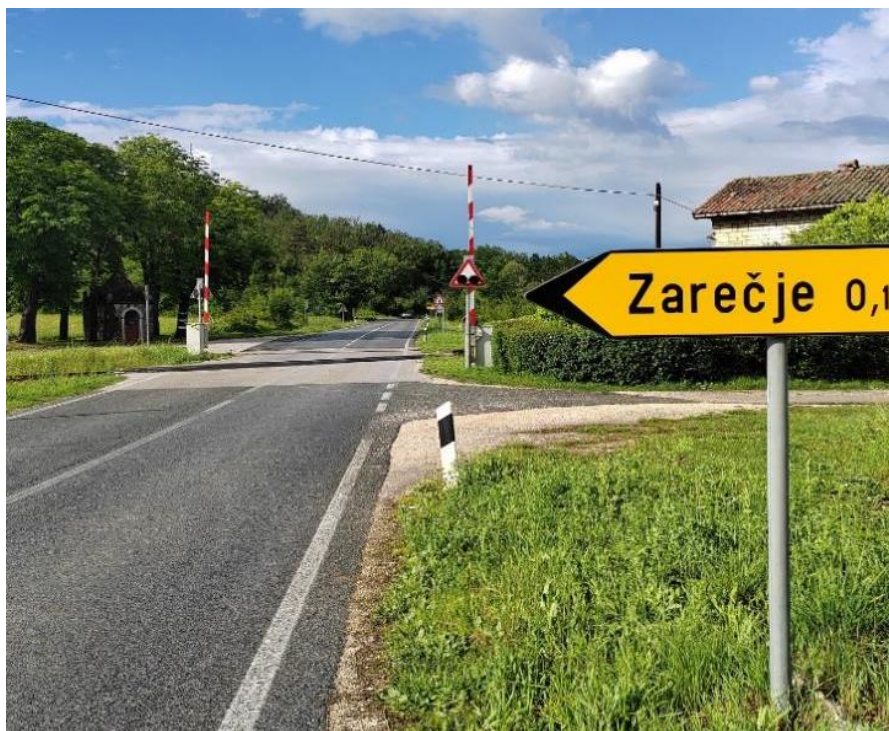
Slika 35. Željezničko-cestovni prijelaz Zarečje iz smjera juga
