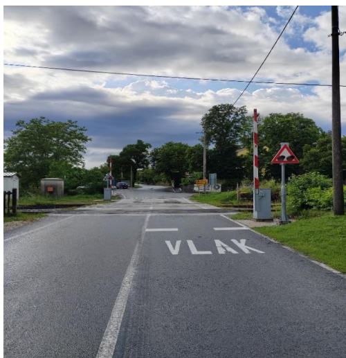
Slika 12. Žcp osiguran svjetlonosno-zvučnom signalizacijom i polubranicima, Cerovlje
