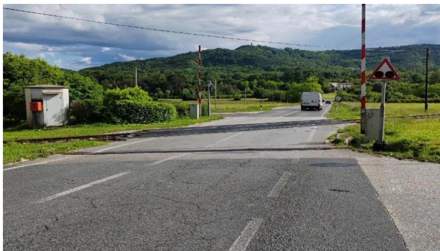
Slika 36. Željezničko-cestovni prijelaz zarečje iz smjera sjevera
