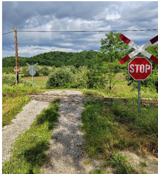
Slika 41. Željezničko-cestovni prijelaz Ćusi
