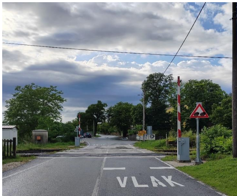
Slika 31. Željezničko-cestovni prijelaz Cerovlje iz smjera juga
