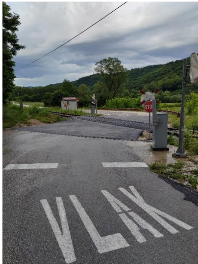
Slika 28. Željezničko-cestovni prijelaz Lovrečići iz smjera sjevera
