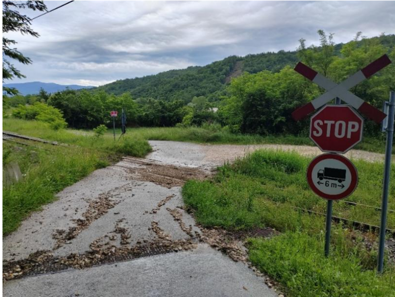
Slika 26. Željezničko-cestovni prijelaz Blagonići 1 iz smjera sjevera
