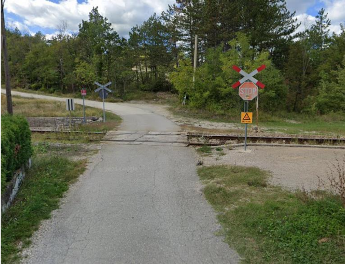
Slika 17. Željezničko-cestovni prijelaz Hum u Istri iz smjera juga
