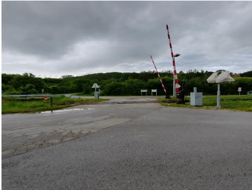
Slika 21. Željezničko-cestovni prijelaz Borut 1 iz smjera juga
