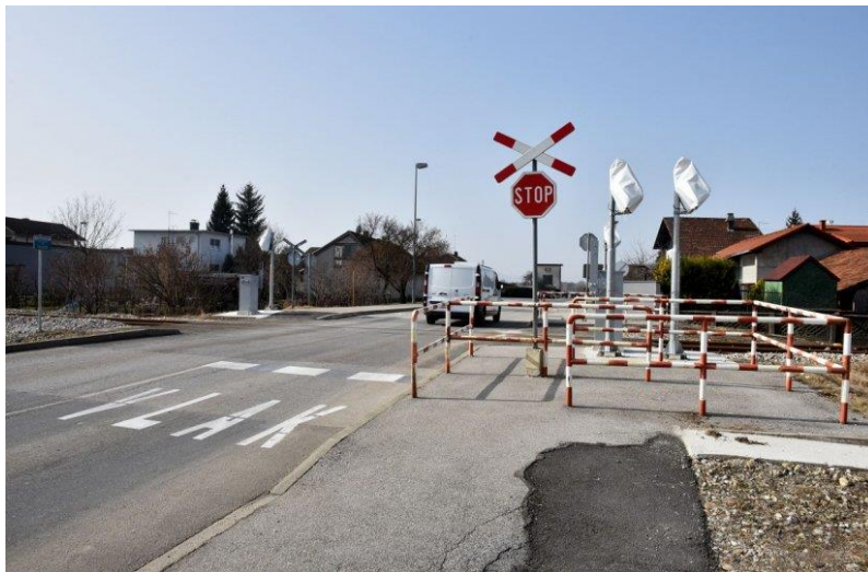
Slika 8. Pješački prijelaz sa pasivnim osiguranjem [9]
