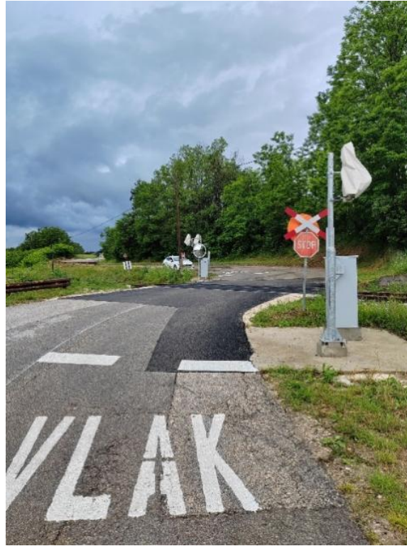
Slika 27. SS uređaji i polubranici u pripremi na željezničko-cestovnom prijelazu Lovrečići
