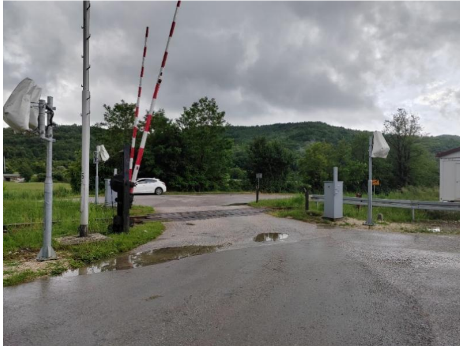
Slika 22. Željezničko-cestovni prijelaz Borut 1 iz smjera sjevera
