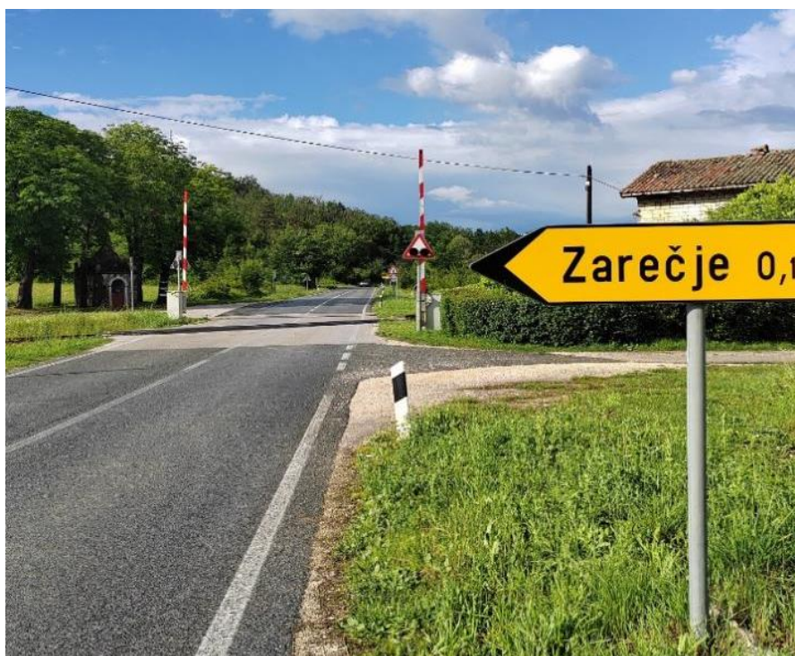
Slika 35. Željezničko-cestovni prijelaz Zarečje iz smjera juga
