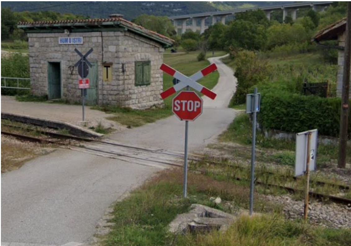
Slika 18. Željezničko-cestovni prijelaz Hum u Istri iz smjera sjevera
