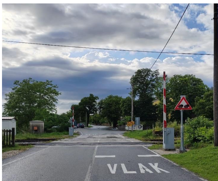
Slika 31. Željezničko-cestovni prijelaz Cerovlje iz smjera juga
