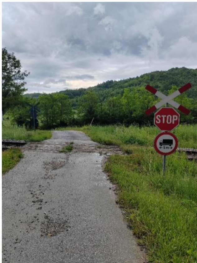
Slika 24. Željezničko-cestovni prijelaz Orlovići iz smjera sjevera
