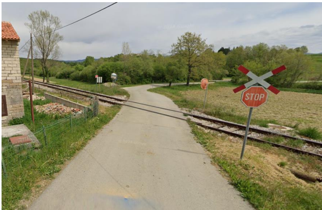
Slika 19. Željezničko-cestovni prijelaz Borut 2 iz smjera sjevera
