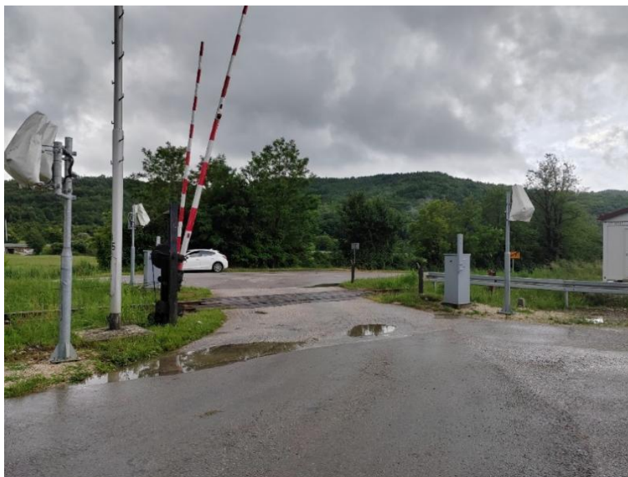
Slika 22. Željezničko-cestovni prijelaz Borut 1 iz smjera sjevera
