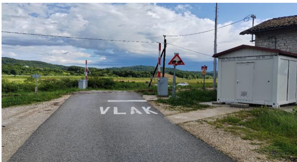
Slika 33. Željezničko-cestovni prijelaz Novaki iz smjera sjevera
