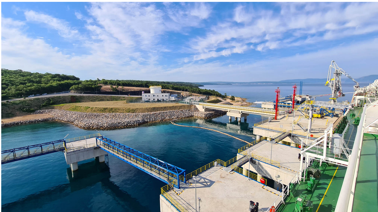
Slika 15. Kopneni dio terminala Omišalj - Krk [20]
