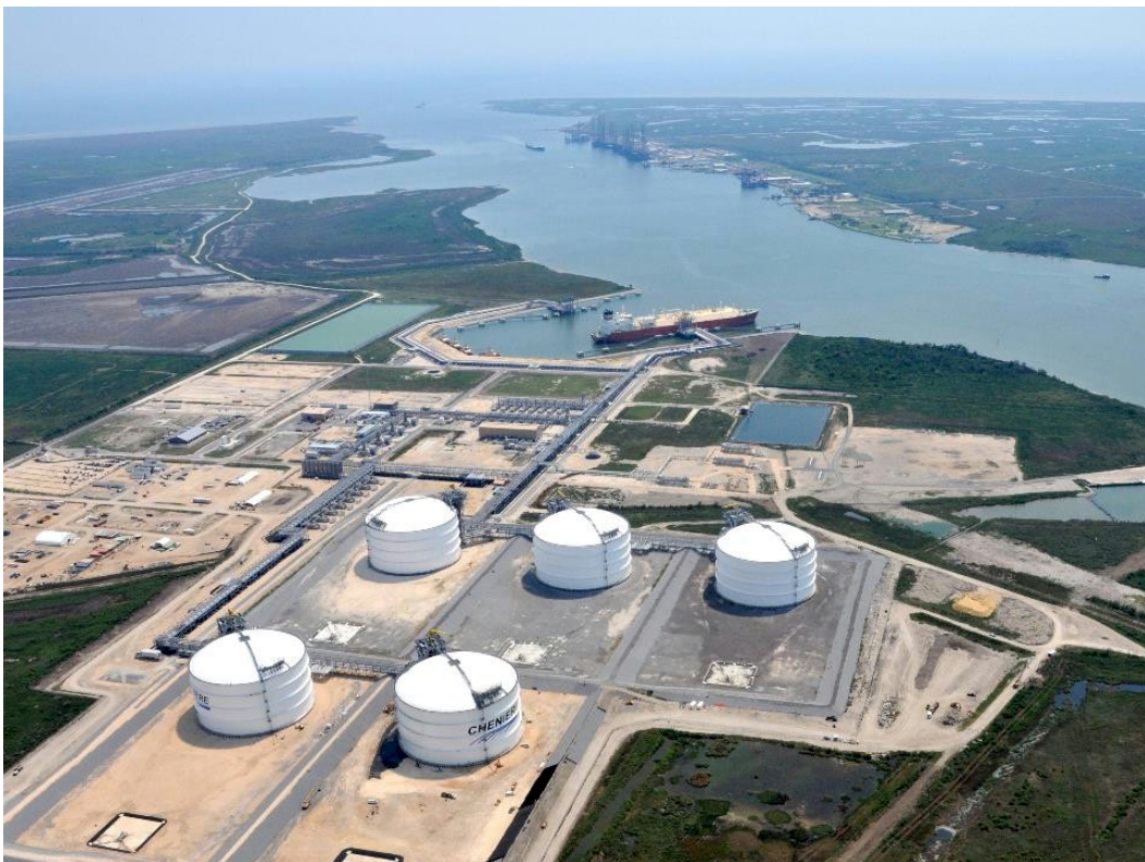
Slika 3. LNG terminal Sabine Pass [33]
