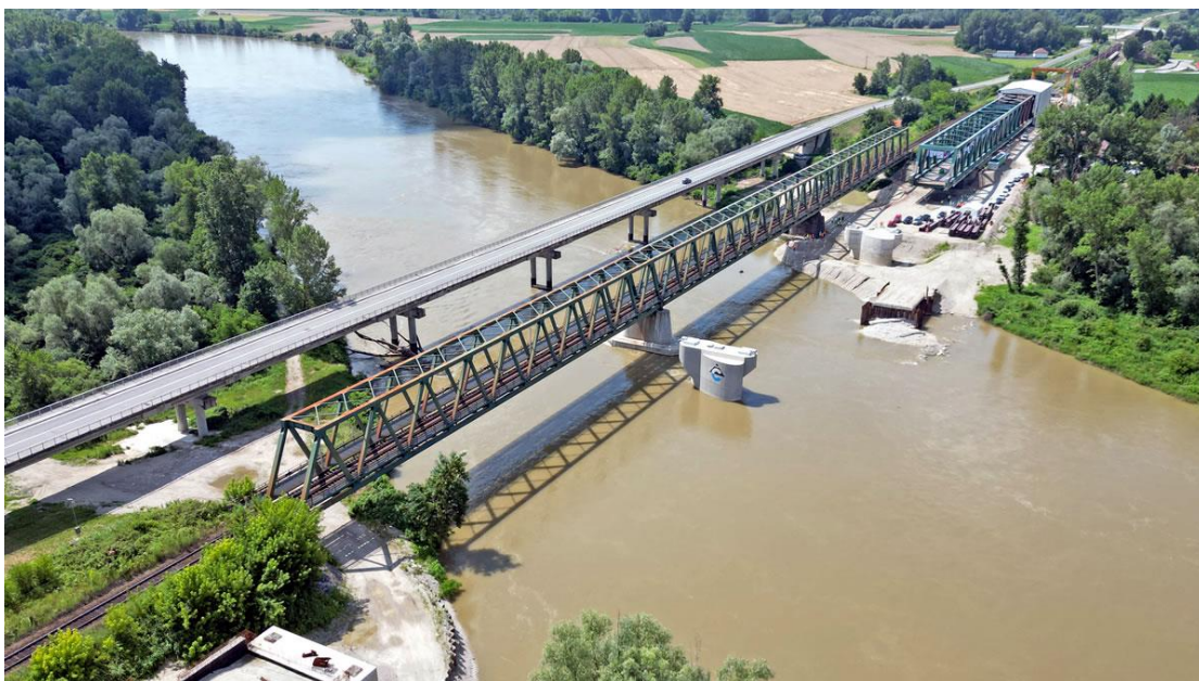
Slika 7. Željeznički most preko rijeke Drave
