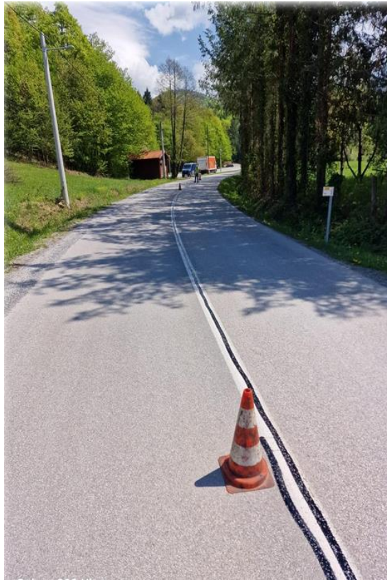
Slika 15: Sanacija pukotina na županijskoj cesti ŽC2219 (Pila)
