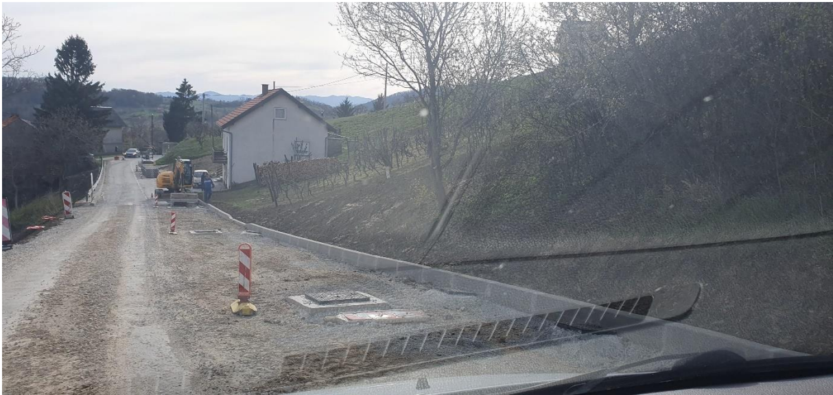
Slika 30: Nanošenje kamenog materijala
