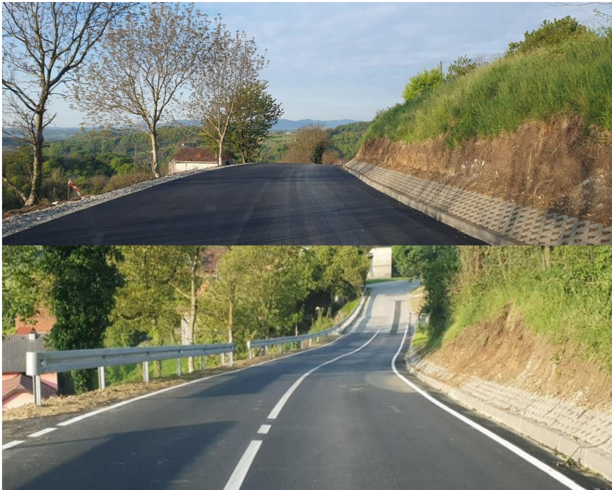
Slika 32: Stanje nakon izvršenih radova sanacije
