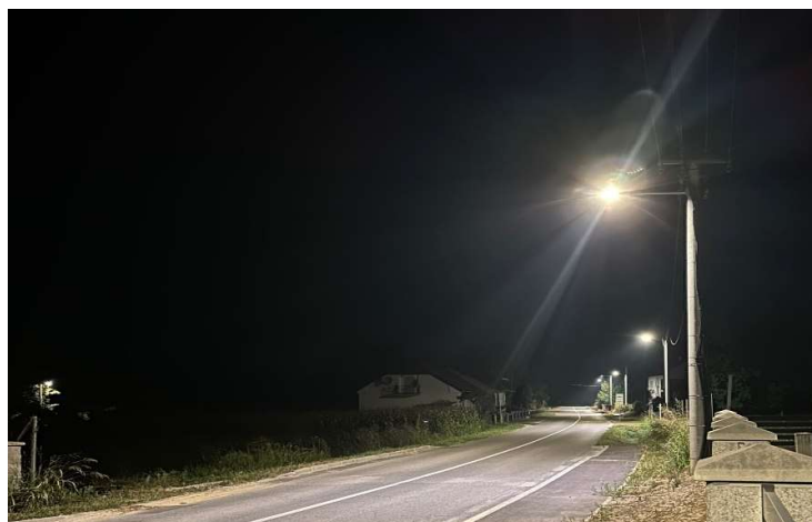
Slika 5. Jednostrani raspored izvora svjetlosti
