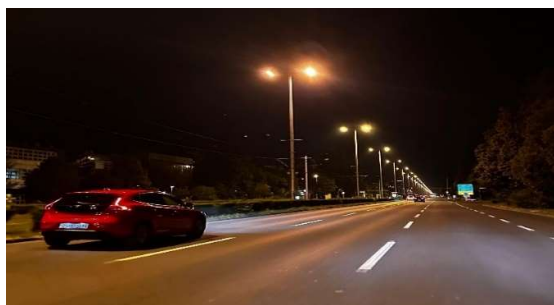
Slika 26. Rasvjeta avenija Dubrovnik
