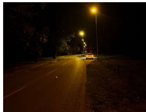
Slika 22. Rasvjeta Borongajske ceste
