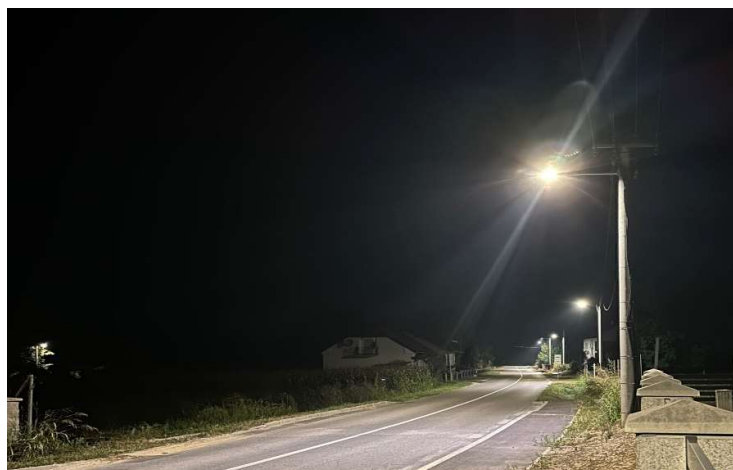
Slika 5. Jednostrani raspored izvora svjetlosti
