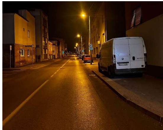
Slika 20. Rasvjeta ulice Matka Baštijana
