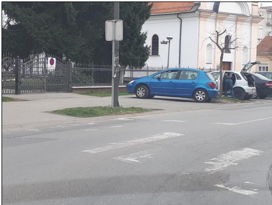
Slika 18. Istrošeni pješački prijelaz
